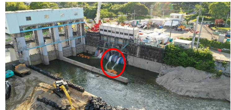
ポンプ設置作業状況(5月24日)
