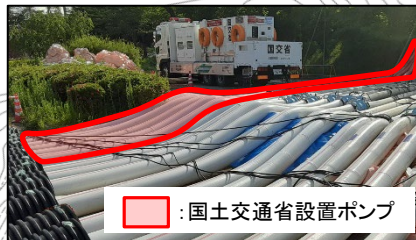
排水ポンプ車①(ポンプ12台)稼働中
