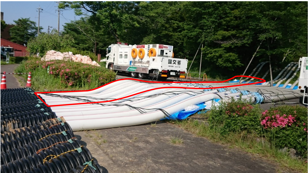
排水ポンプ車① 令和4年5月24日 ポンプ稼働中
