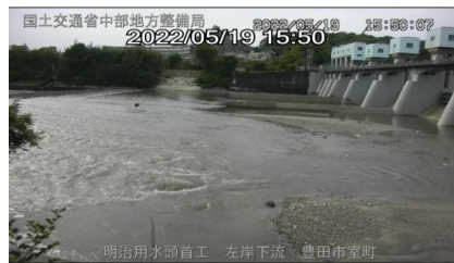
明治用水頭首工 左岸下流(臨時)
