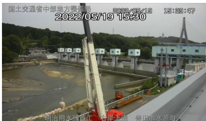
明治用水頭首工 右岸上流(臨時)
