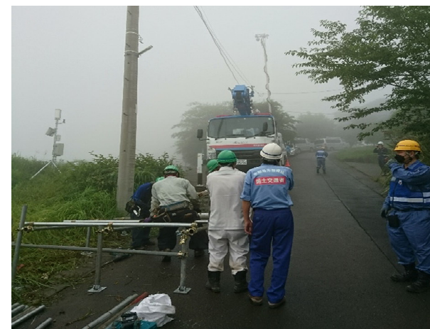
長期化に備え監視カメラの電源状況調査
