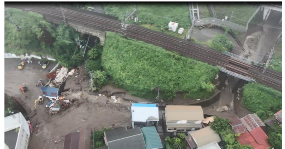
被災箇所のドローン撮影画像(JR在来線付近)
