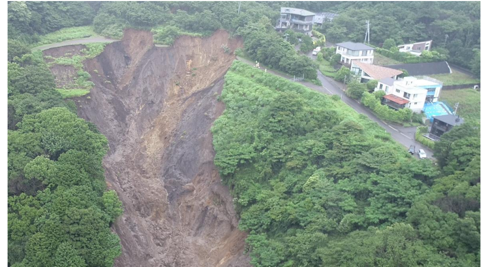
被災箇所のドローン撮影画像(源頭部)
