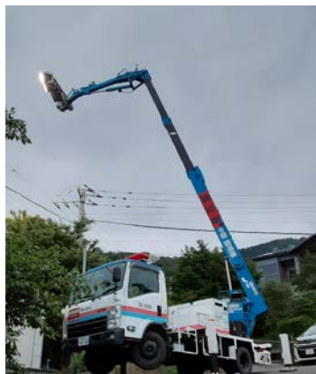
照明車の設置状況
