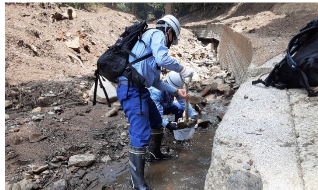
逢初川中流部の被災調査
