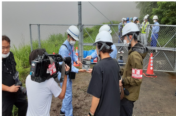
被災箇所ドローン調査中の取材（源頭部）
