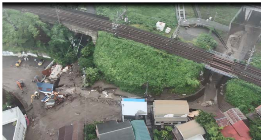
被災箇所のドローン調査(JR在来線付近)
