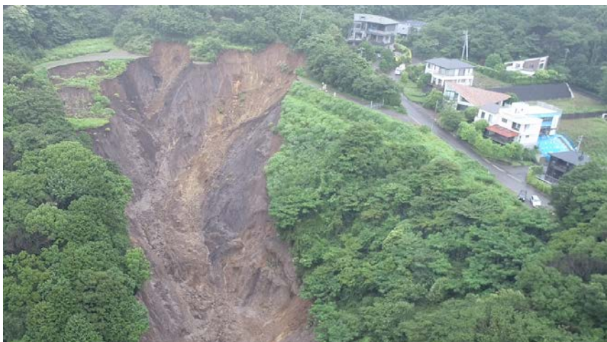
被災箇所のドローン調査(源頭部)
