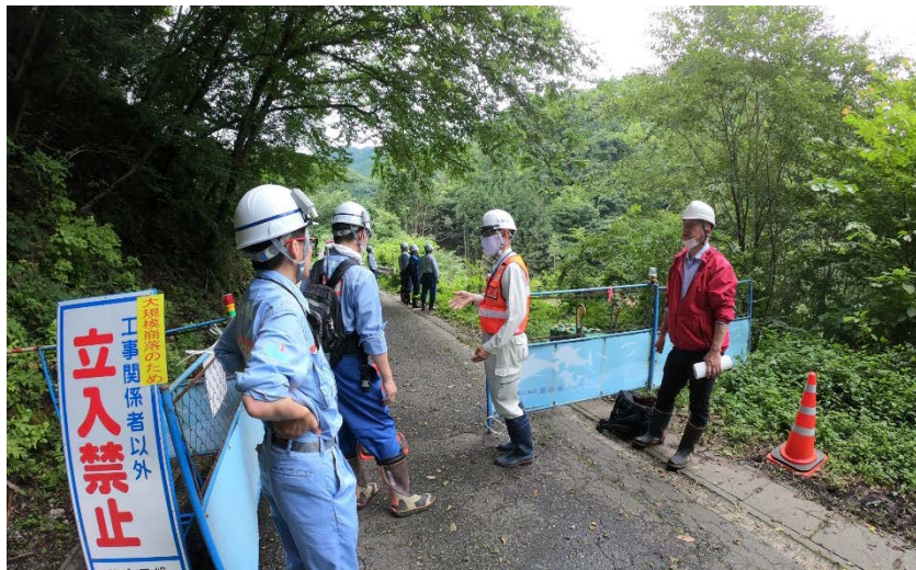
長野県へ被災状況の説明①
