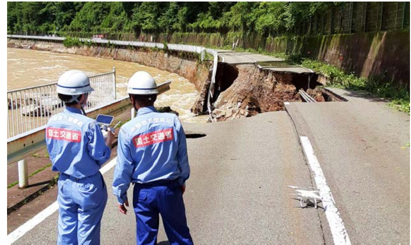
ドローンにて被災状況を調査②
