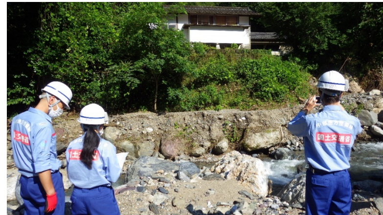
被災状況を調査③(熊本県五木村)
