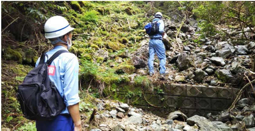
被災状況を調査①(熊本県五木村)
