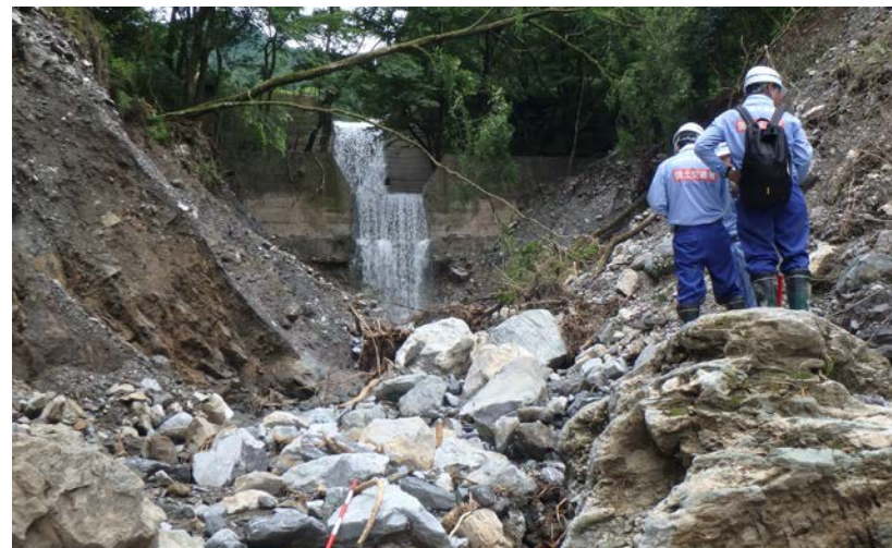
砂防堰堤の調査② (熊本県五木村)
