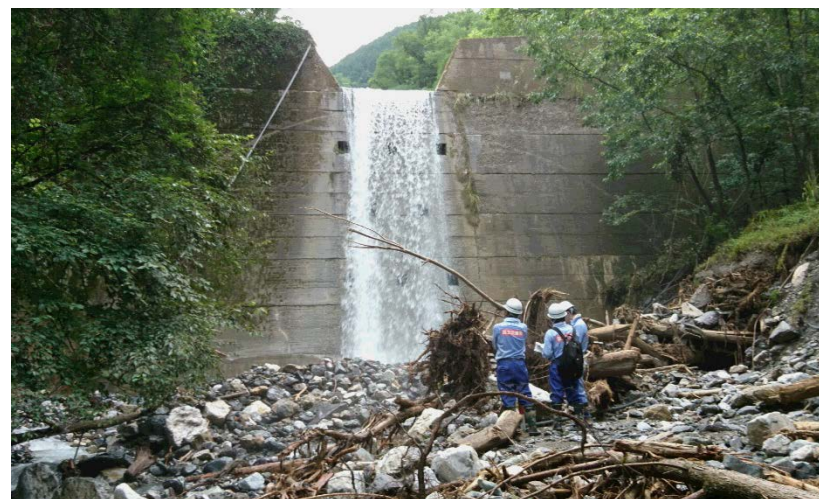
砂防堰堤の調査③ (熊本県五木村)
