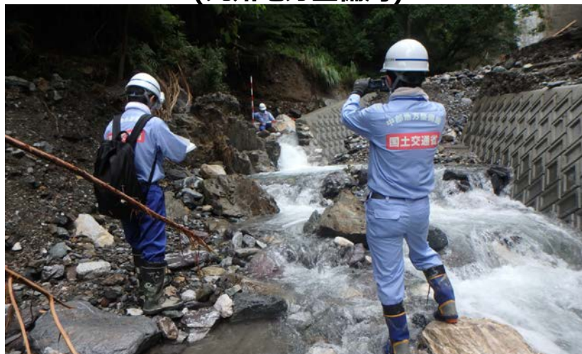
砂防堰堤の調査① (熊本県五木村)
