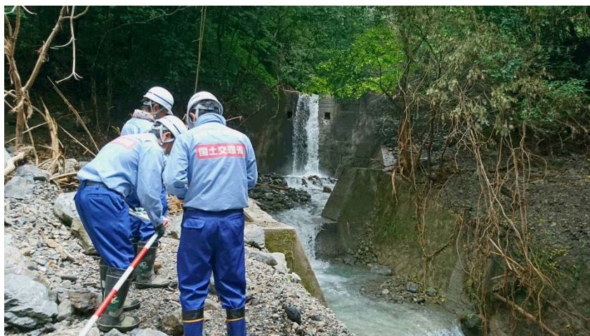
三方谷川砂防堰堤1の調査
