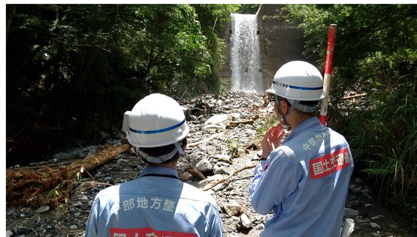
横手谷川砂防堰堤調査
