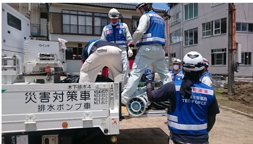
【宝来町雨水ポンプ場での活動状況】
