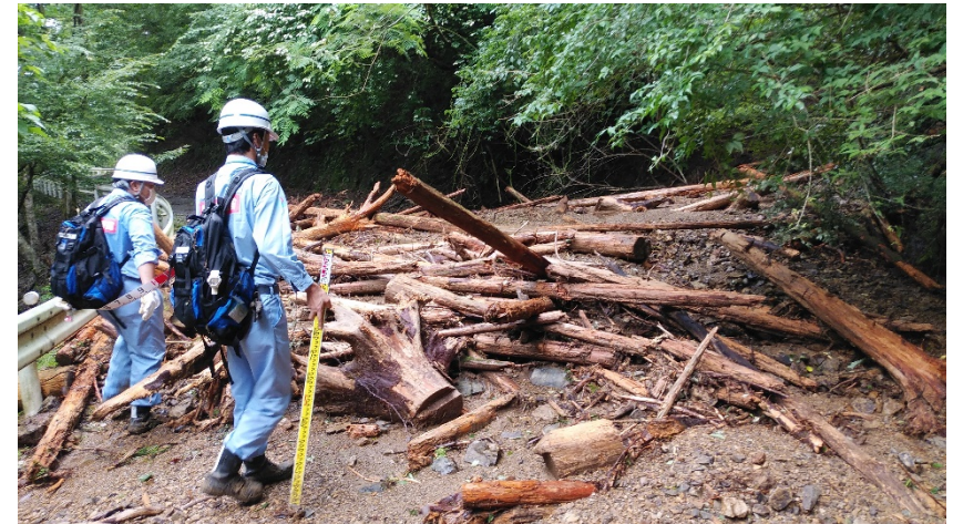
五木村道での被災状況調査
