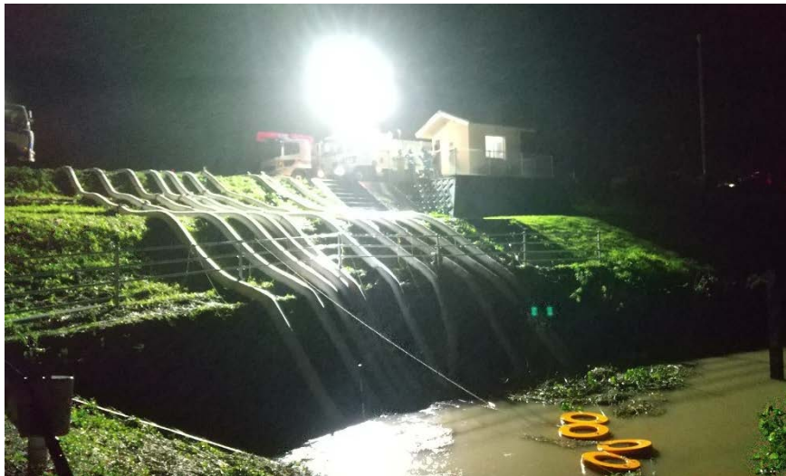
応急対策班の排水作業状況（7月10日深夜）
