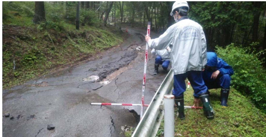
砂防調査班現場調査
