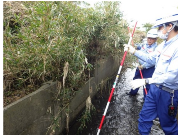
北原川(福島県南相馬市)被災状況調査 (河川調査班)
