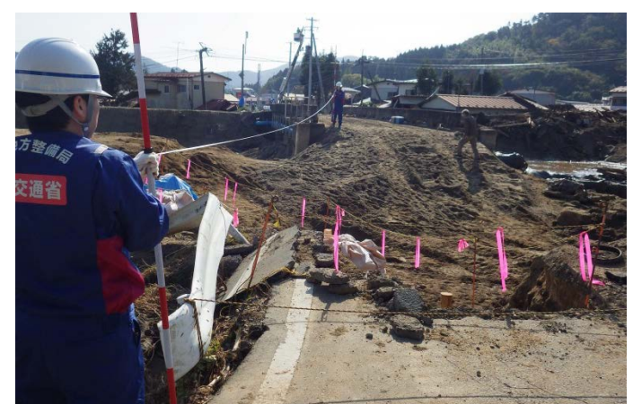
宮城県丸森町字塚田 被災状況調査 （砂防調査班）
