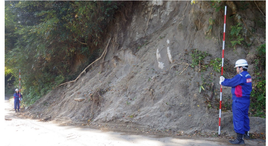
宮城県丸森町字百合沢 被災状況調査（砂防調査班）
