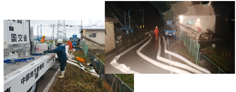
宮城県角田市 排水作業(応急対策班)
