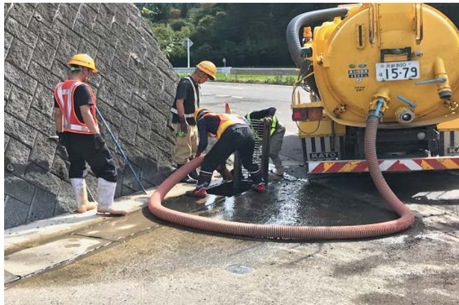
茨城県水戸市での側溝清掃
