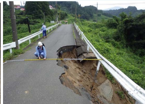
多久市内での現地調査（道路）
