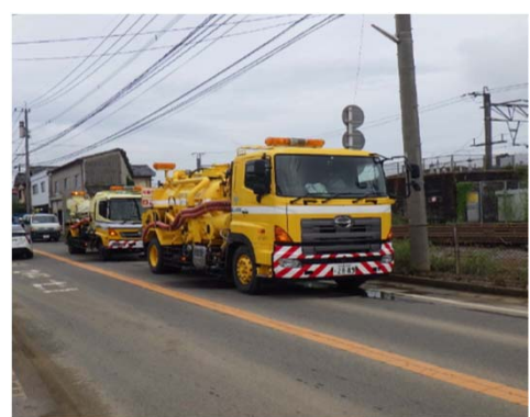
道路側溝の清掃作業
