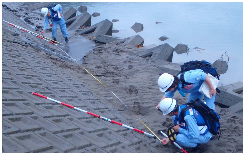
矢部川・巨瀬川における被災状況調査(河川調査2班)
