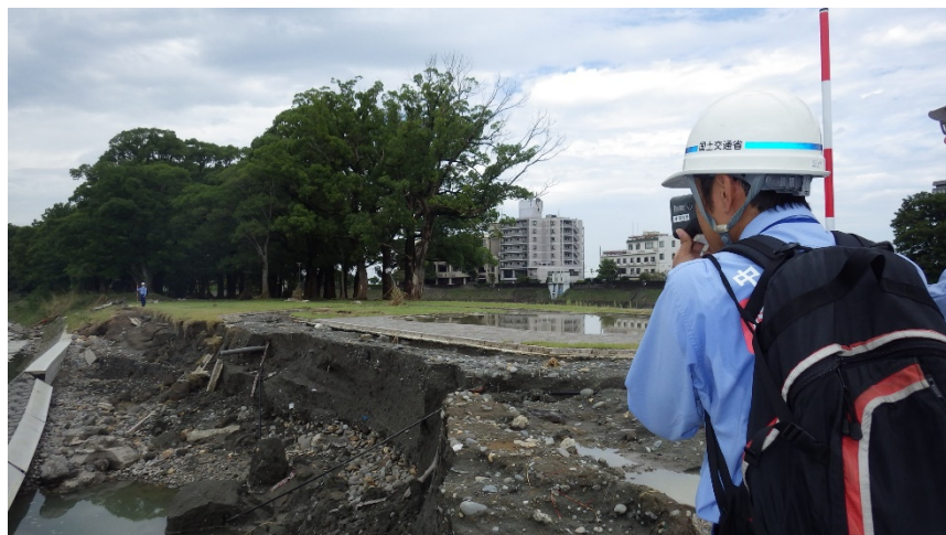
レーザー測距器による被災状況調査(矢部川)(河川調査1班)
