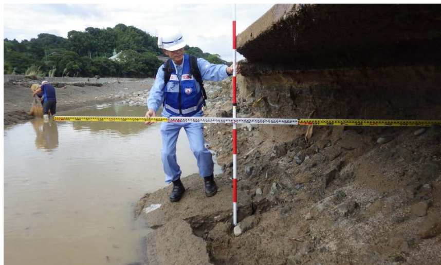
矢部川における被災状況調査(河川調査2班)
