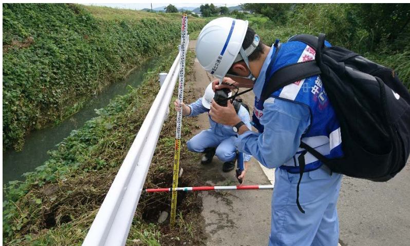
矢部川における被害状況調査(河川調査2班)
