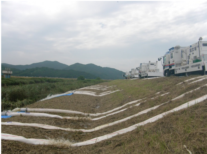
六角川(大町町)での排水作業(排水ポンプ車)
