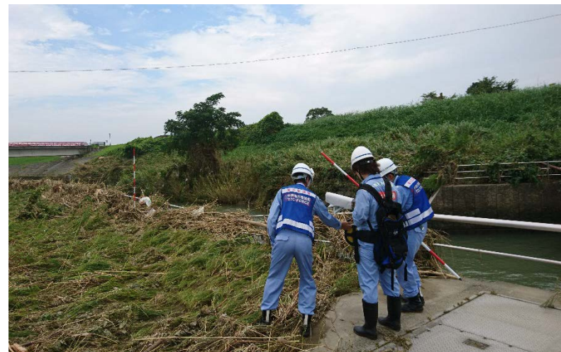
矢部川における被害状況調査(河川調査2班)
