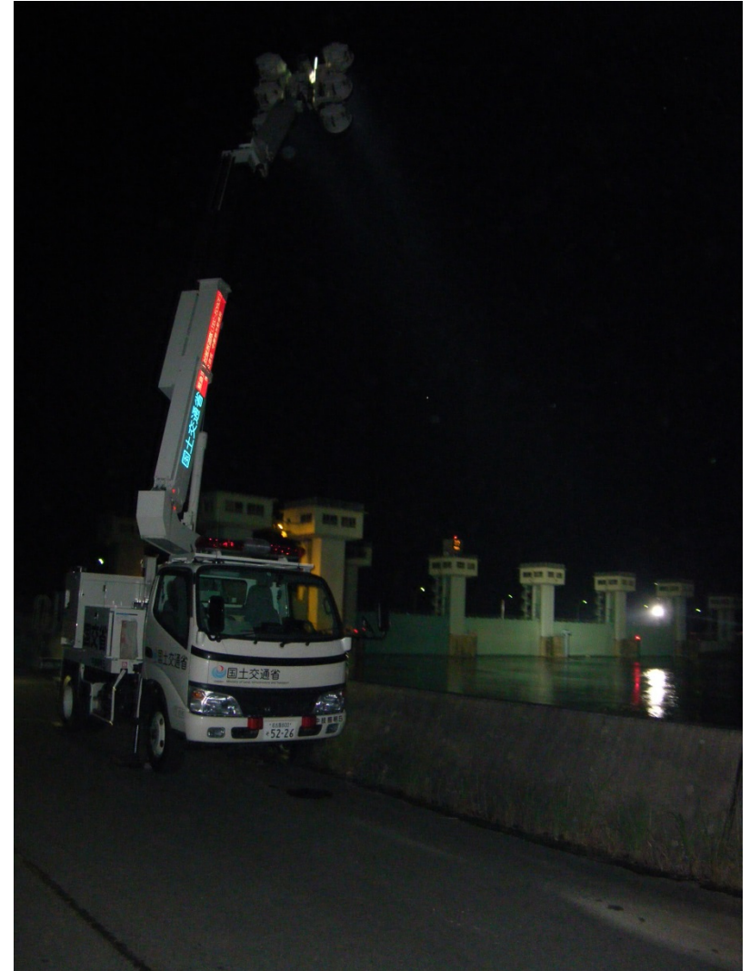
六角川河口堰での夜間作業支援(照明車)
