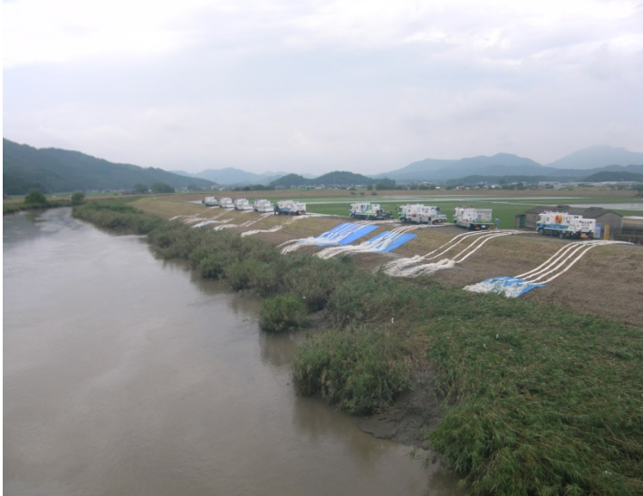
六角川(大町町)での排水作業(排水ポンプ車)
