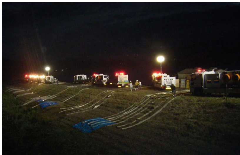
六角川(佐賀県大町町)での排水作業
