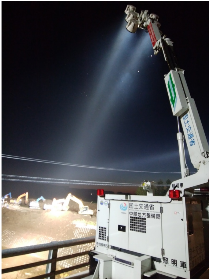
照明車による無人化施工型バックホーの作業を支援
