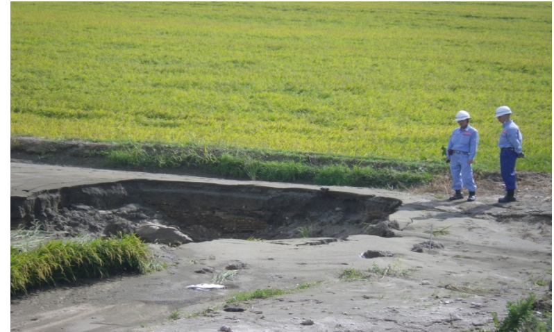
厚真町豊沢地区での調査（道路）
