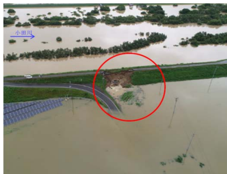
小田川右岸の堤防欠損箇所(岡山県倉敷市真備町)
