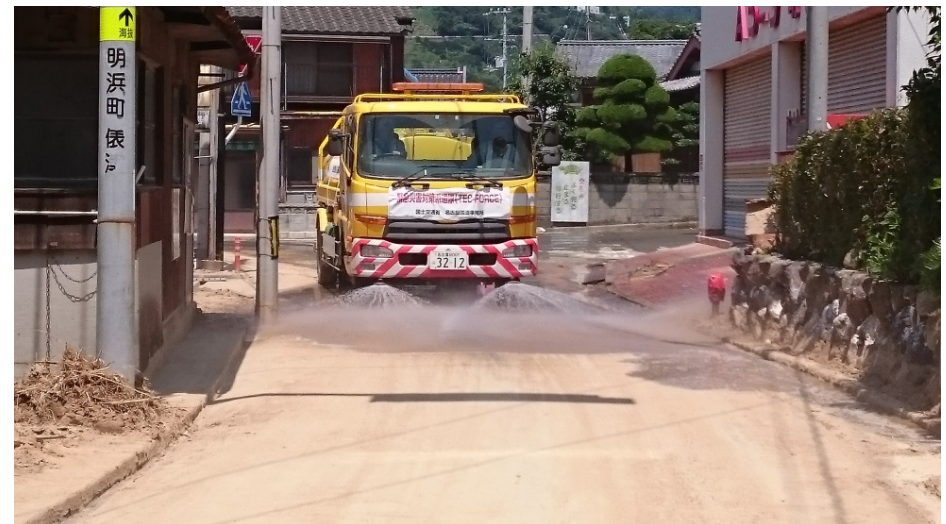
散水車による路面清掃作業
