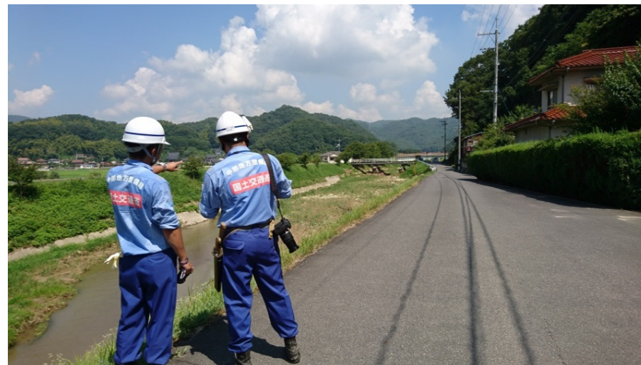
菅川橋梁への樹木の付着状況確認
