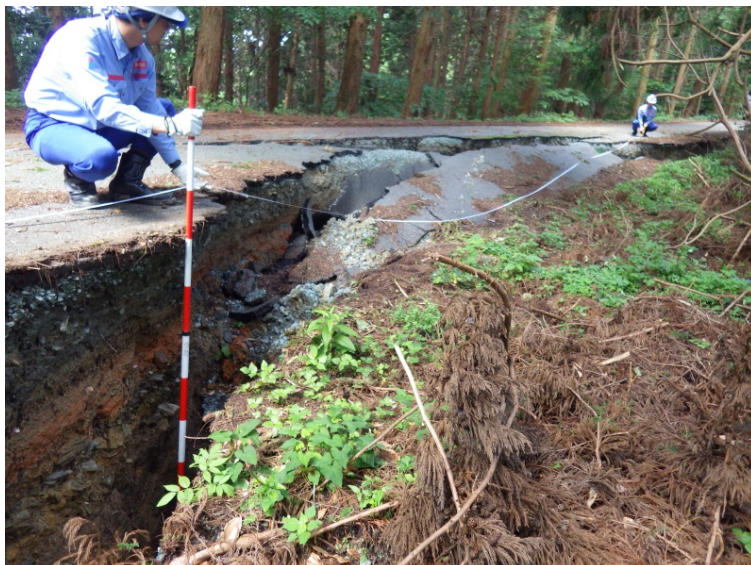
大洲市内での現地調査②（河川）
