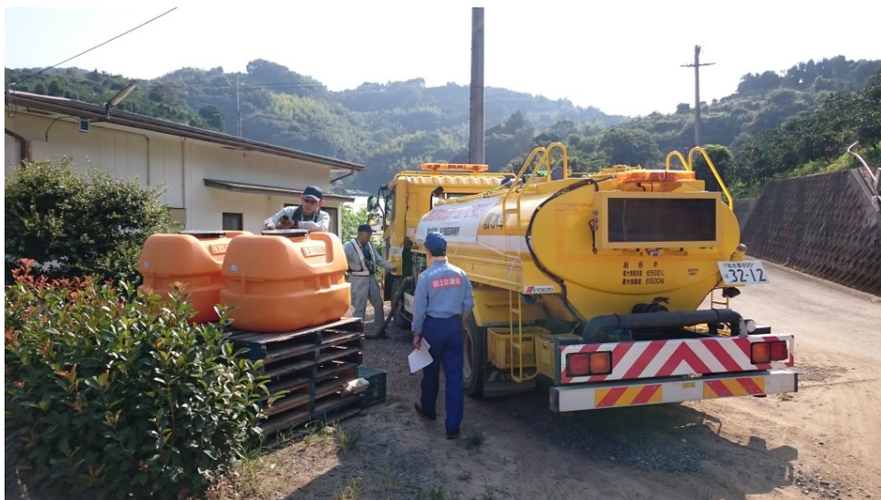
宇和島市内において生活用水の給水活動②
