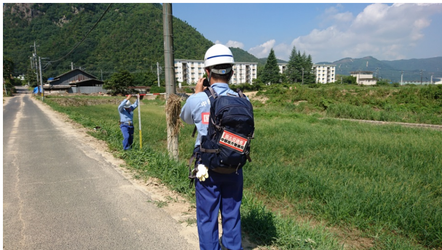
沼田川水系菅川 本川合流点付近において現地調査
