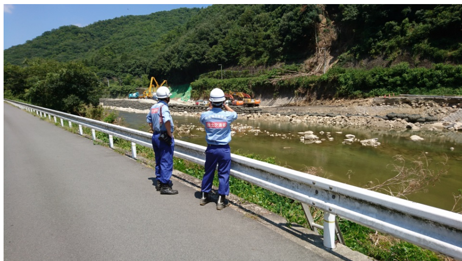
沼田川において上流の状況確認
