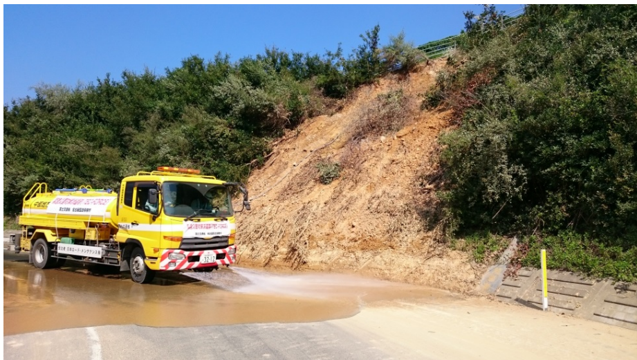
散水車による路面清掃作業
