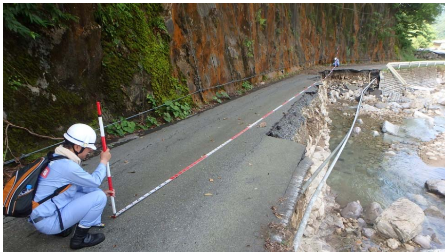
下呂市内での現地調査（道路）
