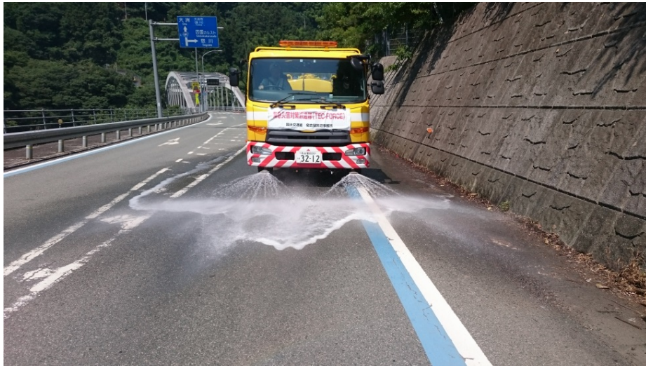
散水車による路面清掃作業 (7/15)
