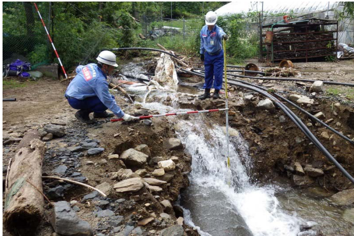
釜石市橋野町地内市道 現地調査
