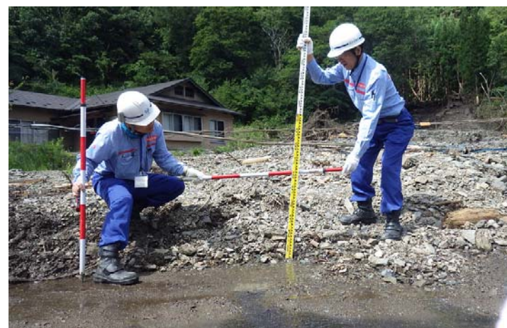
砂防調査状況(岩泉町釜津田地区)
