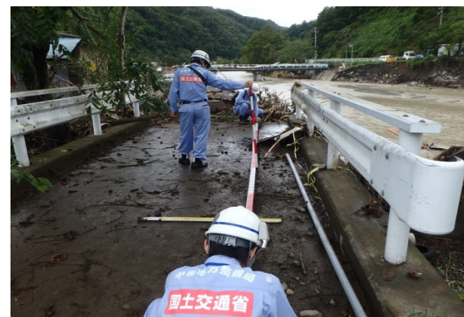
岩泉町で町道被災状況調査
