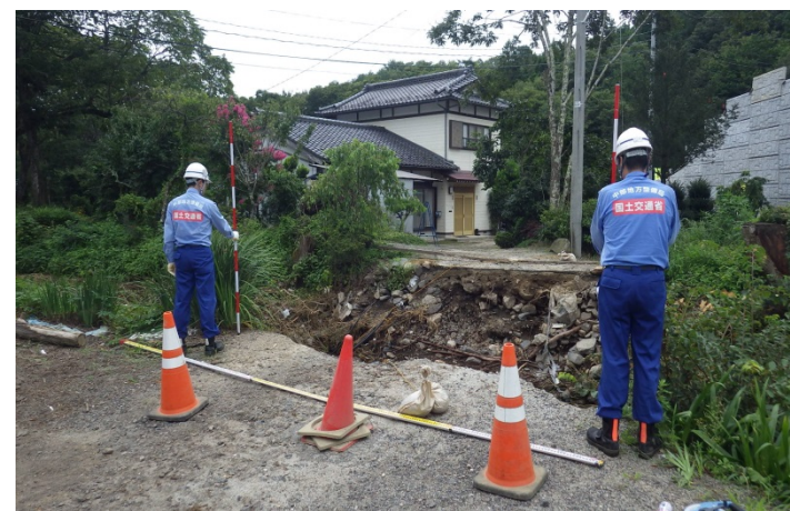
宮古市高浜地区 被災状況調査
