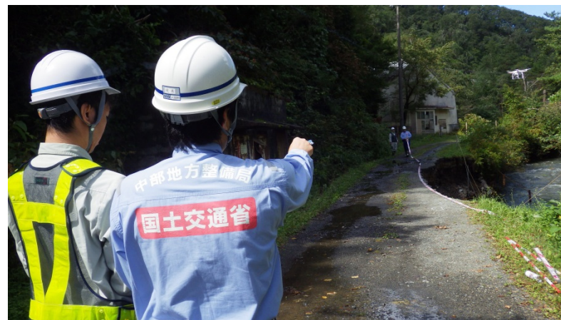
宮古市田老地区被災状況調査
