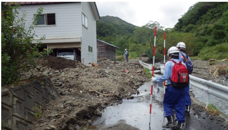
岩泉町南沢地区町道被災状況調査
