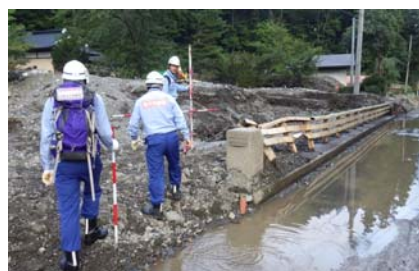
【宮古市 閉伊川 被害状況調査】
