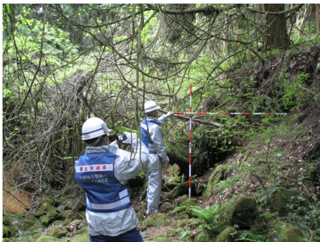
金山川被災状況調査
