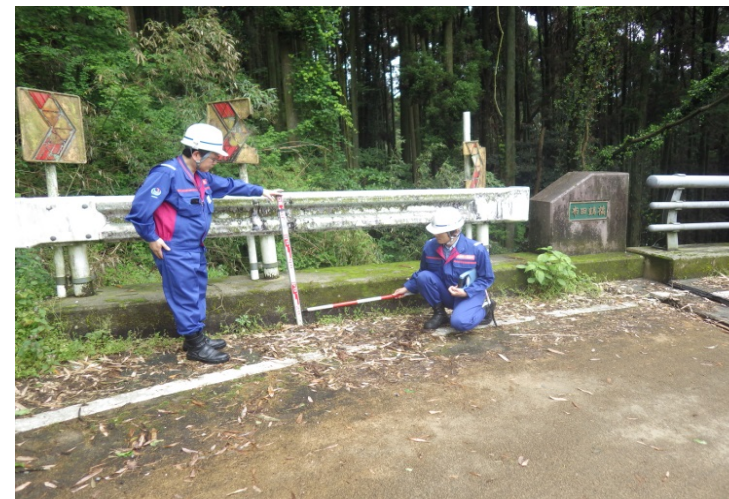
西原村布田鶴橋現地調査
