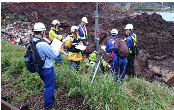
崩落箇所における伸縮計確認調査(阿蘇大橋)
