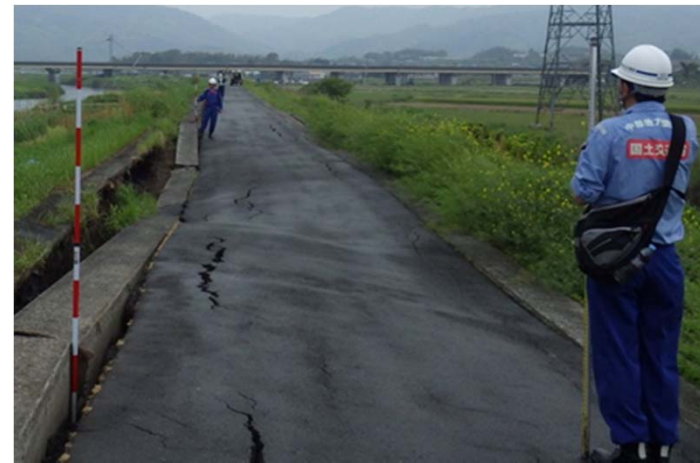
堤防の被災状況調査(緑川支川)
