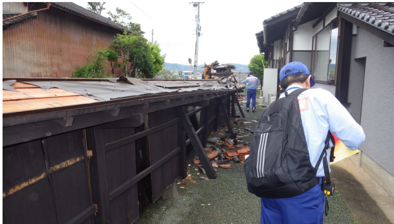
熊本市東区での建築物危険度判定調査
