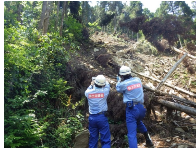
西原村木山川被災状況調査
