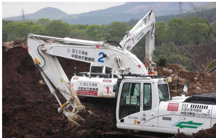
遠隔操作中の無人バックホウ(阿蘇大橋崩落現場)
