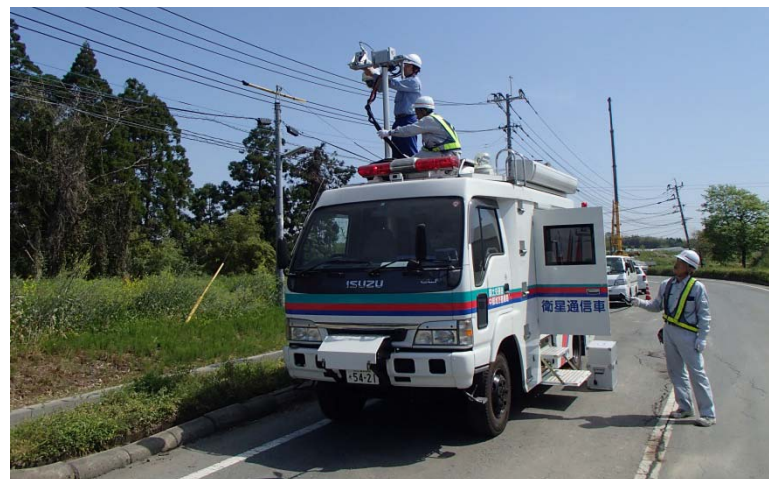
陥没現場映像配信状況(国道443号)
