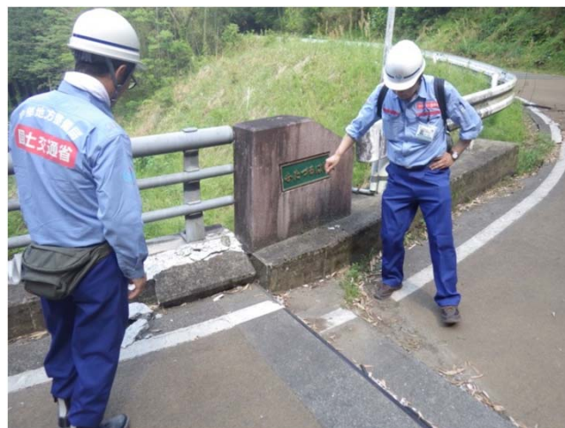
布田鶴橋被災状況調査
