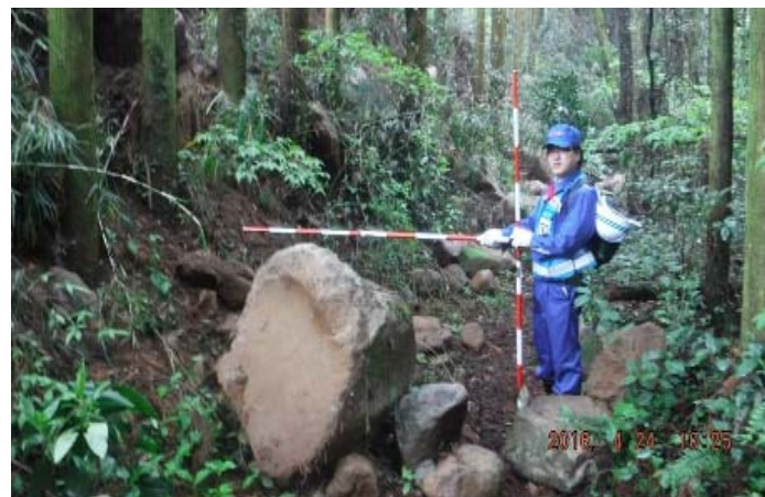
砂防の被災状況調査(西原村布田川砂防)
