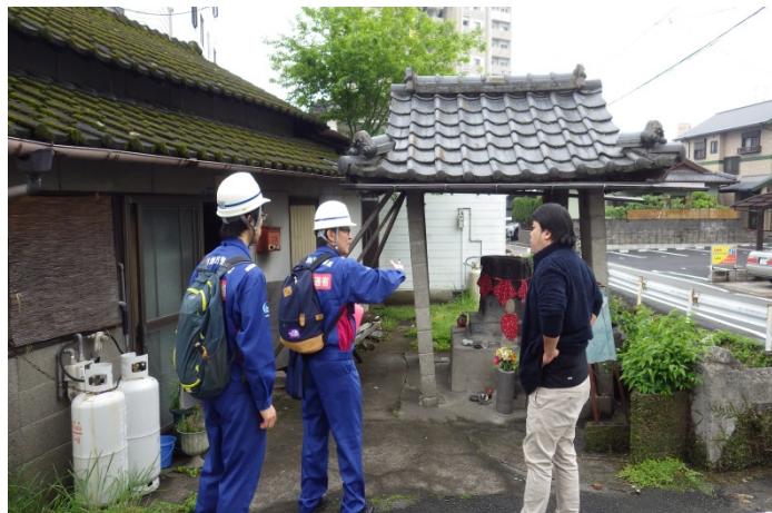
建築物の応急危険度判定調査(熊本市内)
