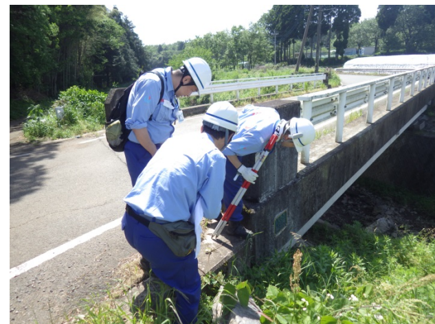
西原村 下鶴橋被災状況調査
