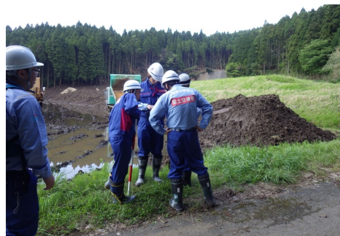
山王谷川砂防堰堤現地調査
