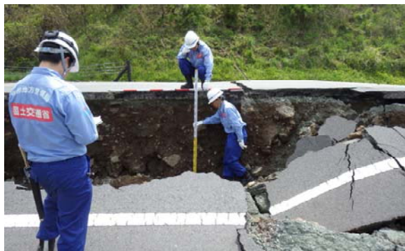
【西原村における被災状況調査】
