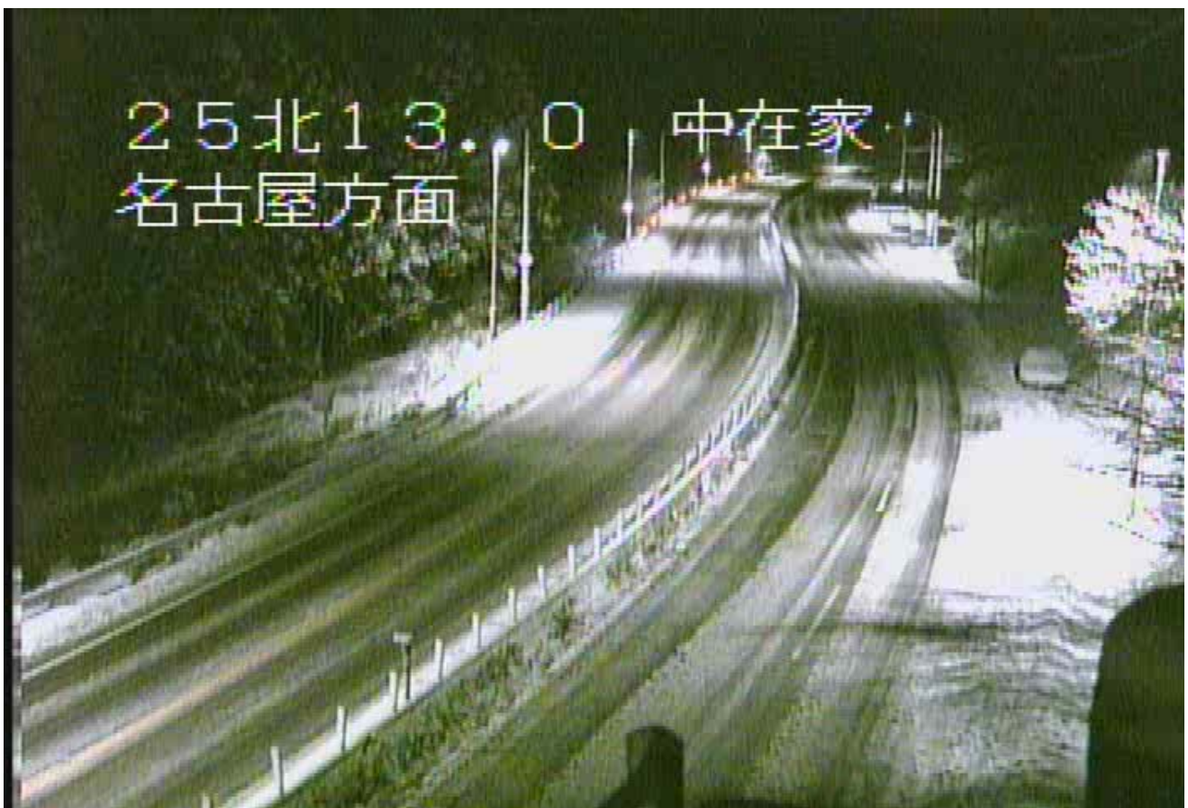
滞留車両の排除後の状況 1月3日 5時
