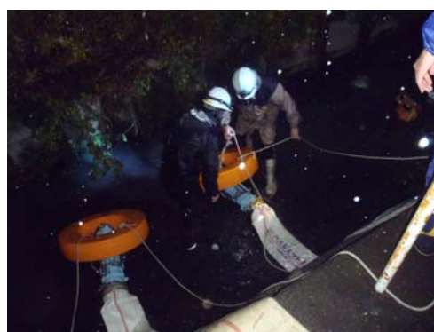
【静岡市（巴川）の排水ポンプ車の作業状況】
