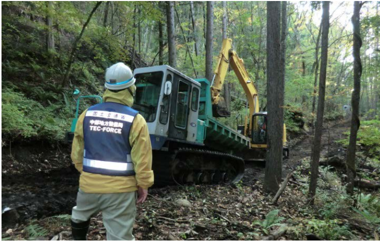
鹿ノ瀬川の砂防堰堤設置工事における搬入路造成作業
