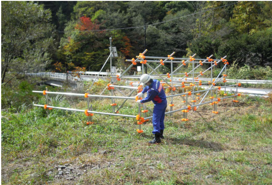
省メンテナンス化のため、太陽光パネルの設置準備
