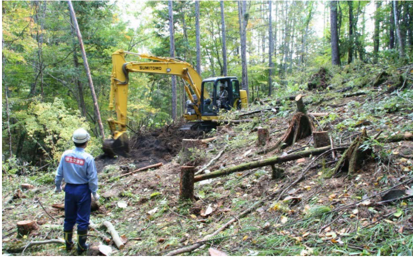
鹿ノ瀬川の砂防堰堤設置工事における進入路造成作業
