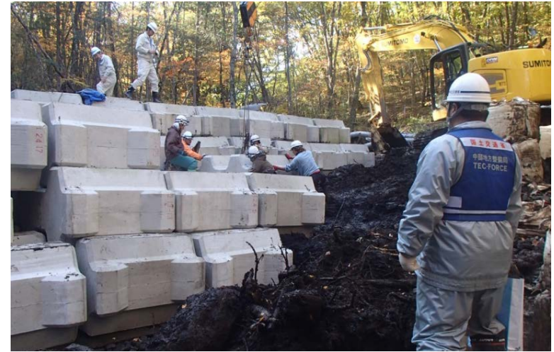
砂防堰堤ブロック据え付け作業(10/24)
