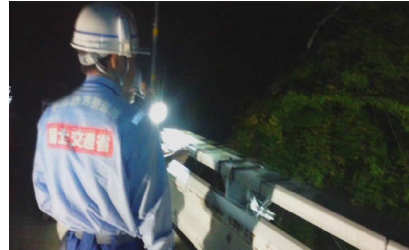
監視カメラの照明を設置
