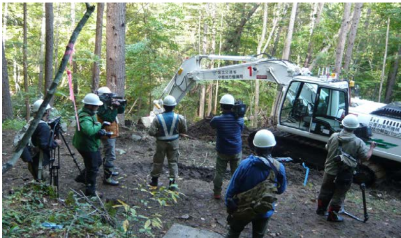
現場に搬入された遠隔操作無人化施工バックホウ
