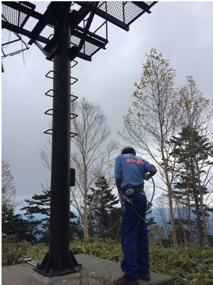
安全帯(命綱)を装着して、監視カメラの保守作業を行うTEC-FORCE隊員
