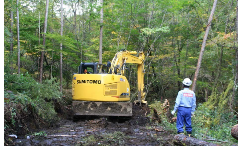
鹿ノ瀬川の砂防堰堤設置工事における進入路造成作業
