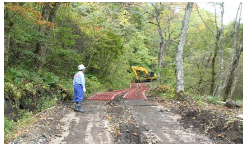
砂防堰堤設置工事における進入路造成作業
