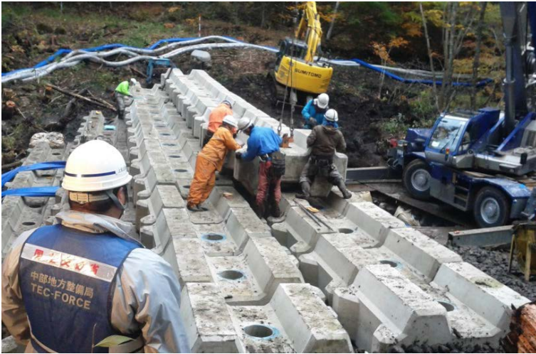
砂防堰堤ブロック据え付け作業(10/23)
