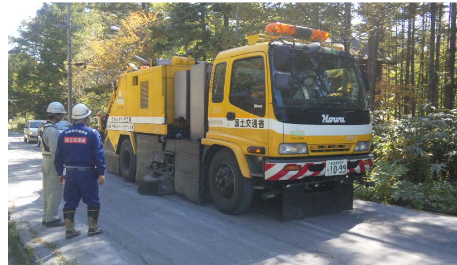
路面清掃車により降灰除去作業を実施
