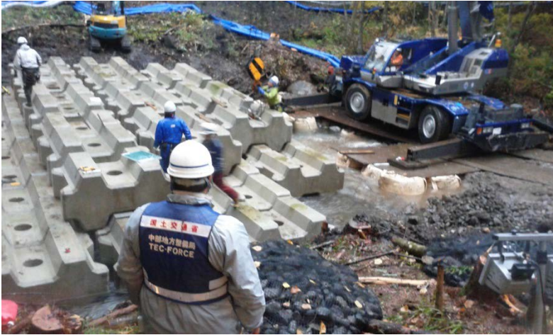
砂防堰堤ブロック据え付け作業
