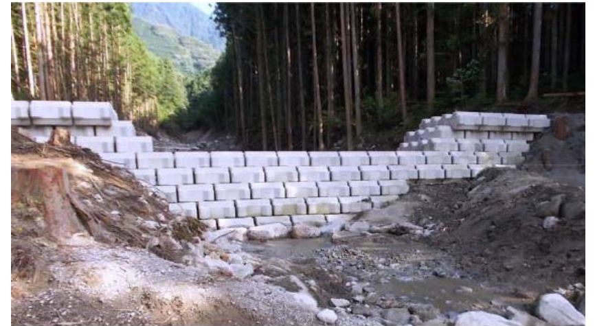
鹿ノ瀬川に設置されるコンクリートブロック積み砂防堰堤イメージ
