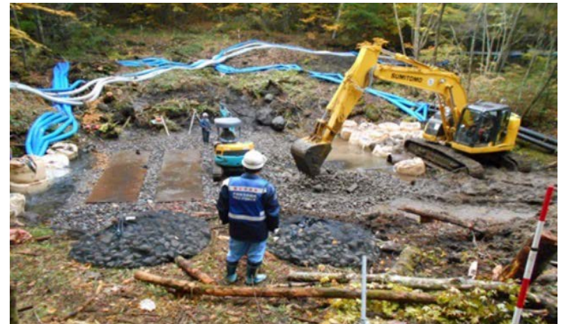
河床部の床付け作業
