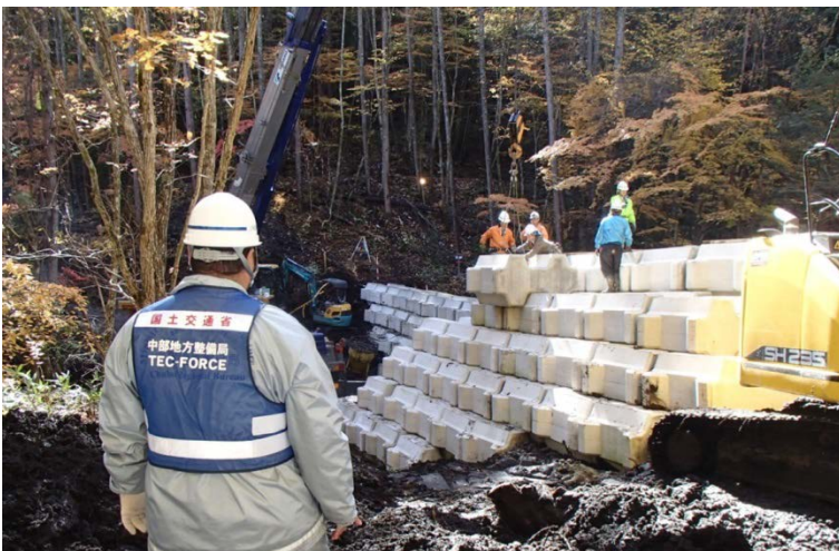
砂防堰堤ブロック据え付け作業(10/25)
