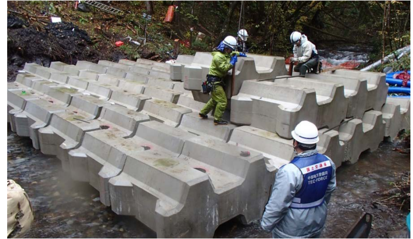
砂防堰堤ブロック据え付け作業
