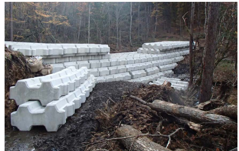
砂防堰堤ブロック据え付け作業 完了(10/28)
