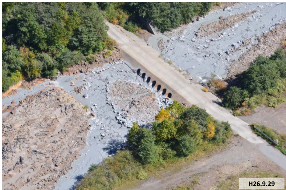
濁沢川の土石流発生前の状況(9/29)、林野庁ワイヤーセンサー設置箇所付近)
