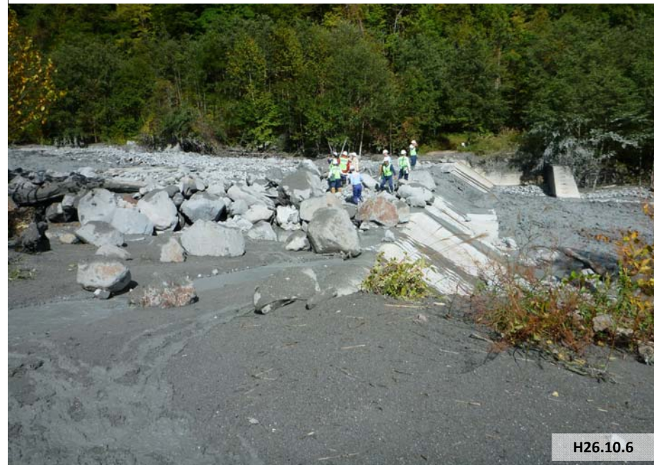
濁沢川の土石流発生状況(10/6、林野庁ワイヤーセンサー設置箇所付近)
