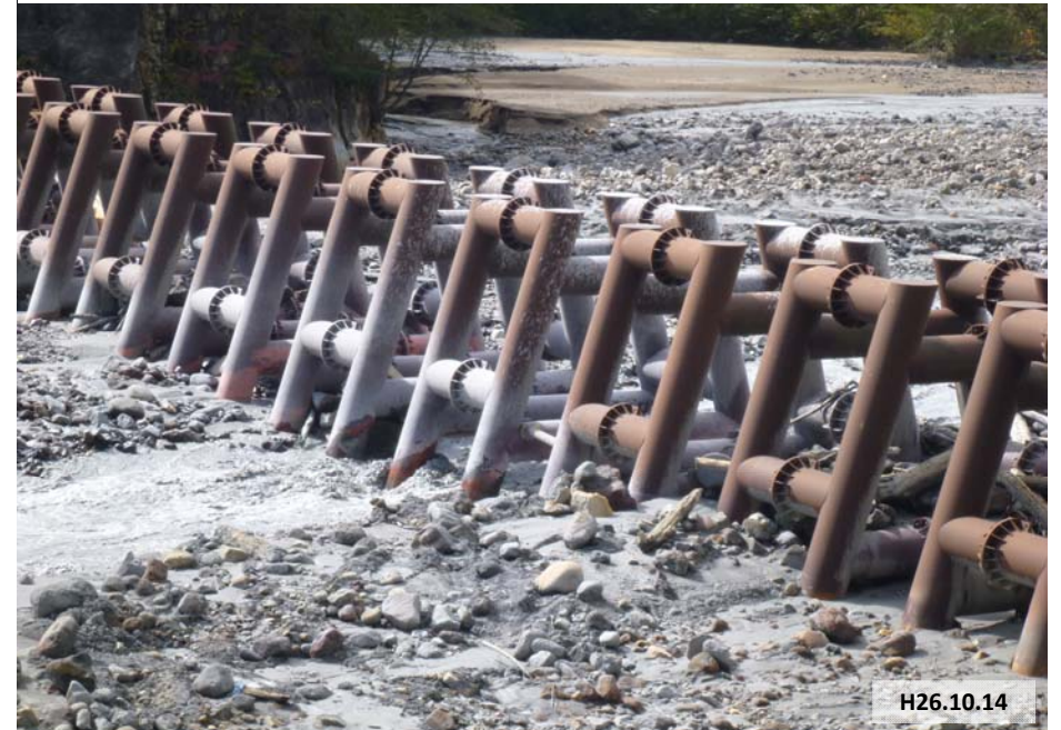
国土交通省ワイヤーセンサー設置箇所付近の状況(10/14)
