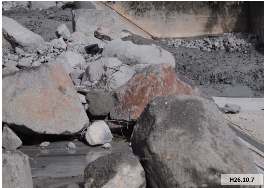
濁沢川の土石流堆積状況(10/7、林野庁ワイヤーセンサー設置箇所付近)
