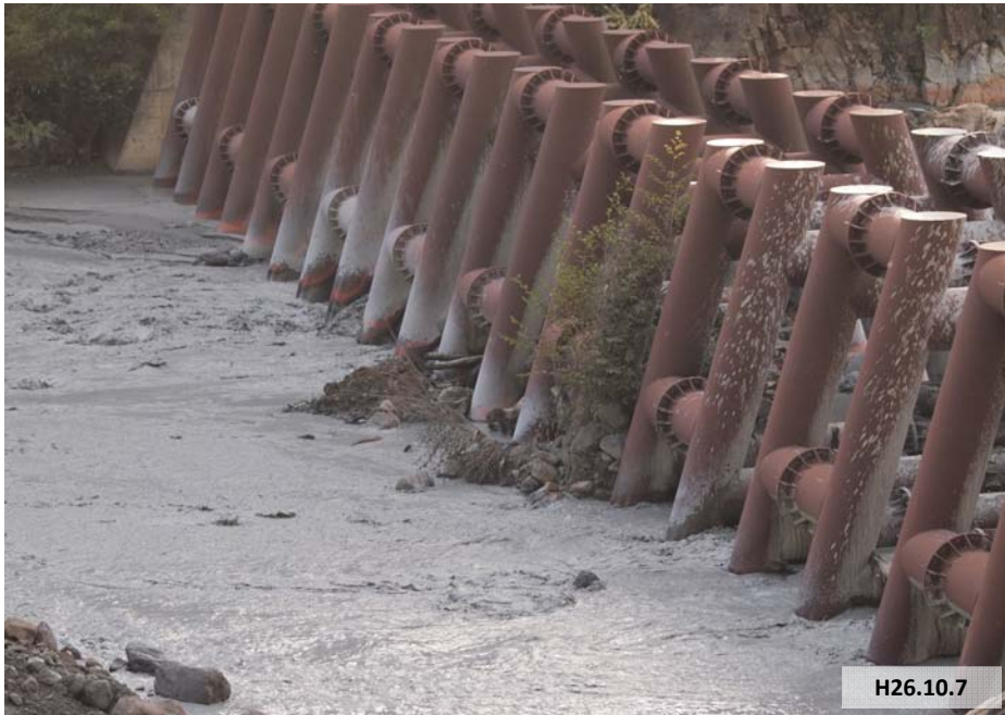
国土交通省ワイヤーセンサー設置箇所付近の状況(10/7)
