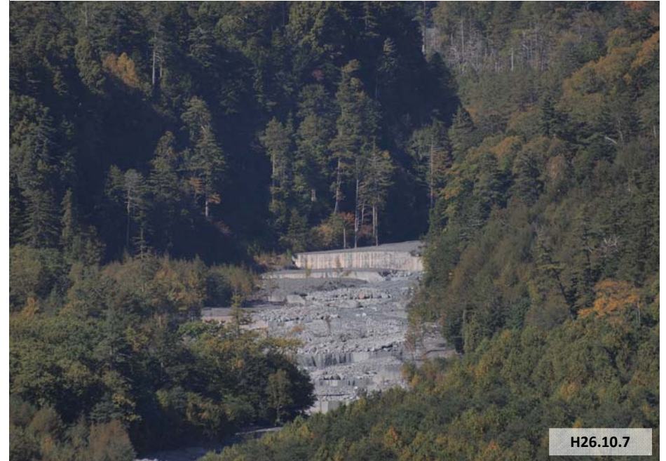
濁沢川の土石流堆積状況(10/7、林野庁ワイヤーセンサー設置箇所付近より上流を望む)
