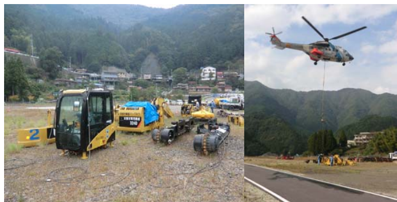
空輸状況(H23台風12号奈良県にて)
