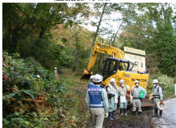
(重機搬入状況)
