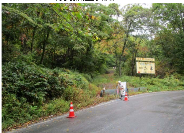
(現場測量状況)
