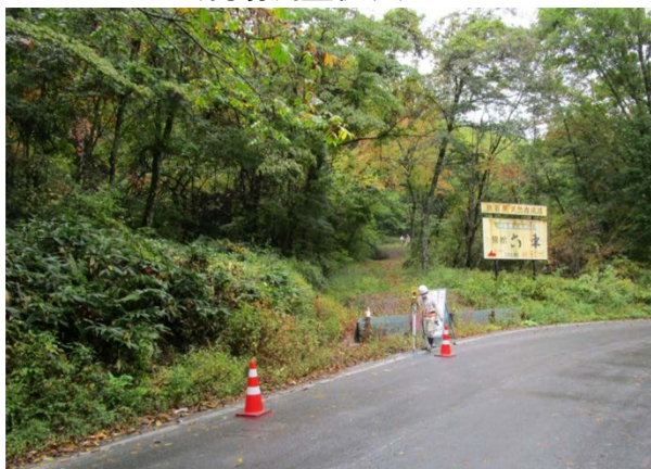
(現場測量状況)
