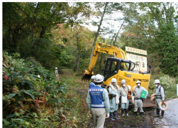
(重機搬入状況)
