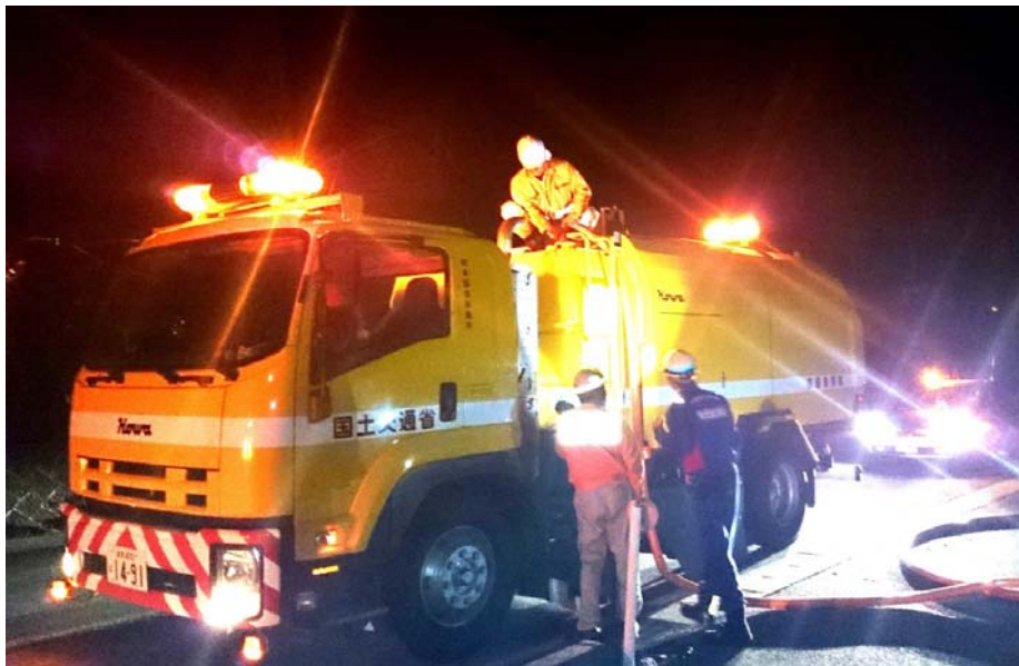
木曽町道 鹿ノ瀬線における降灰除去作業
