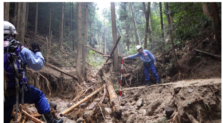
広島市安佐北区大林町地先の被災状況調査②
