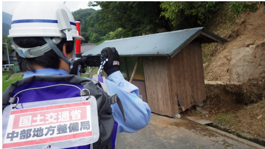
広島市安佐北区大林町地先の被災状況調査①
