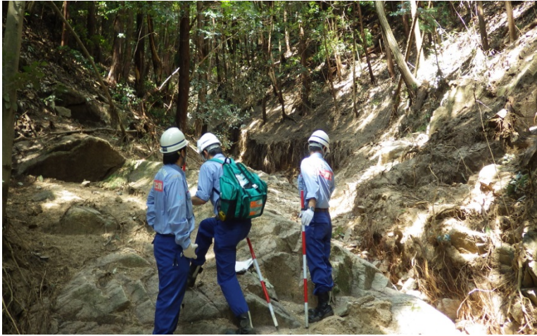
広島市安佐北区大林町地先の被災状況
