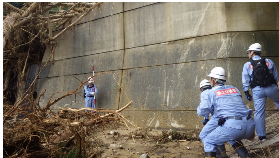
現地状況を調査
