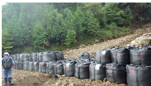
【大型土のう設置状況】
