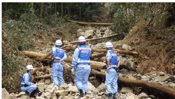
【応急復旧対策に向けた調査状況】
