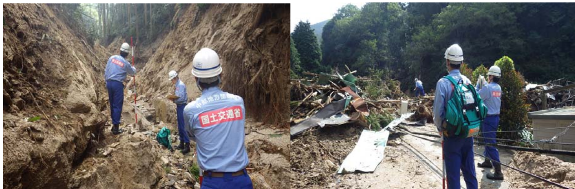
【安佐北区大林町地内での現地調査の状況】
