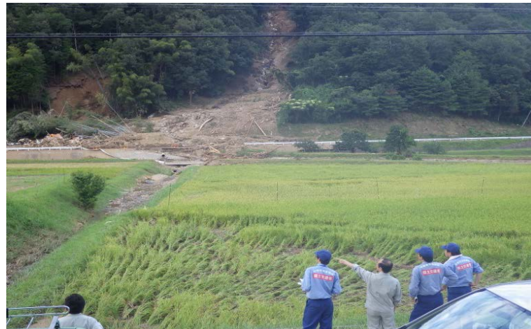
被災箇所の現地調査
