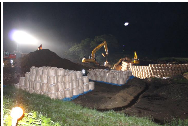
照明車を使用し盛土工施工状況
