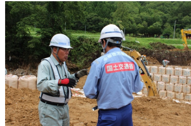
施工業者と打合せ状況
