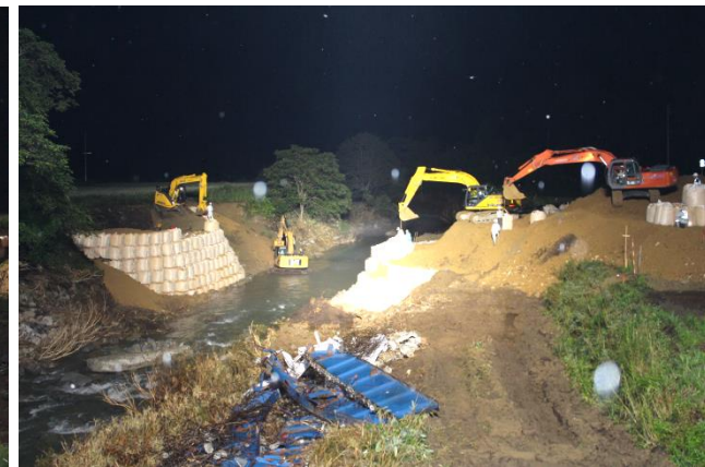
照明車を使用し両岸の土嚢土工施工状況
