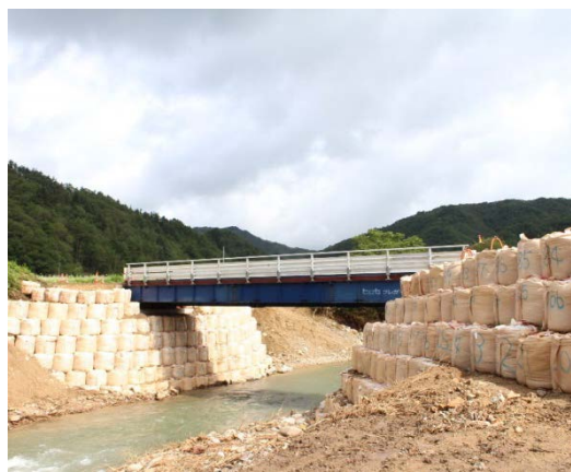
仮橋架設状況
