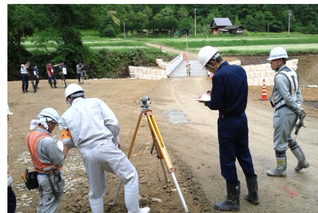
開通前の高山市による検査
