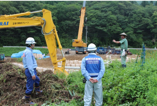
工事状況を説明
