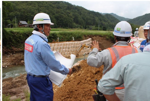
土嚢積み及び盛土工施工指導
