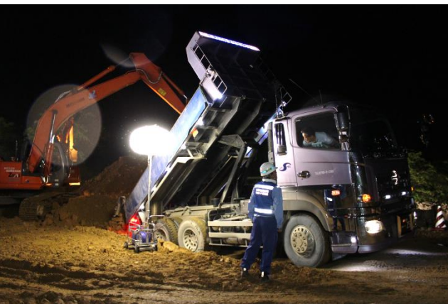
盛土工用土砂搬入状況
