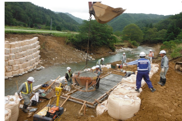
右岸仮橋受台コンクリート打設状況
