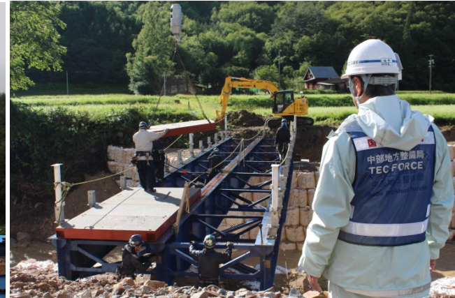
覆工板設置状況
