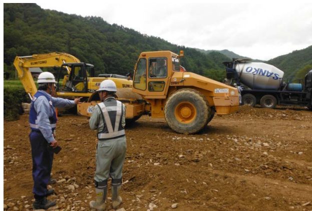
転圧施工状況
