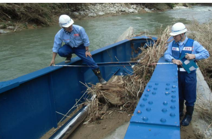
TEC—FORCE隊員による落橋した宮前橋上部工の調査状況(写真左)及び仮橋設置のための測量作業(写真右)
