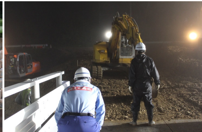
右岸取付部土工施工状況
