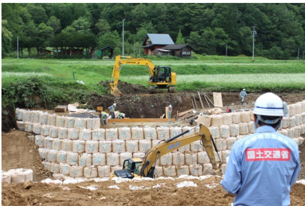
左岸仮橋受台型枠設置状況
