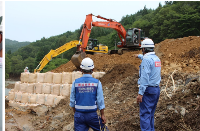
土嚢積み施工確認状況
