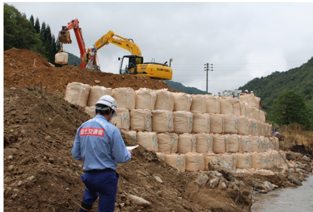
土嚢積み施工状況(右岸側)
