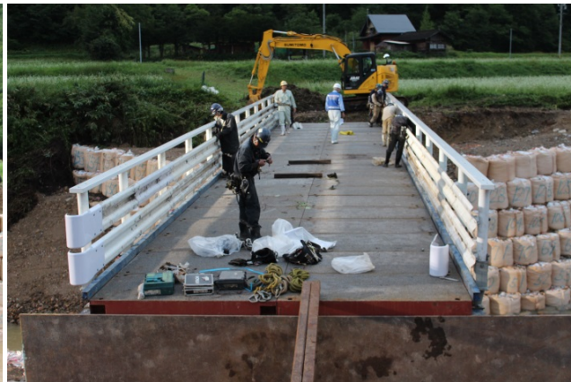
ガードレール設置状況
