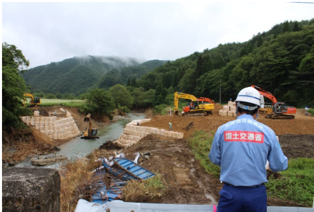
施工状況(上流→下流)
