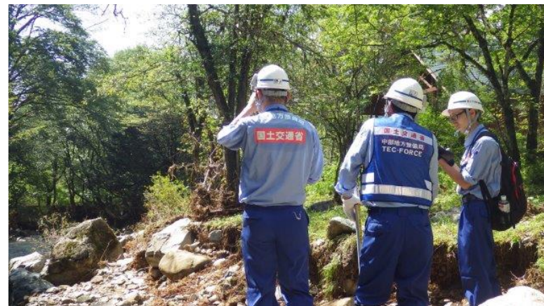
南平谷川(清見町櫛谷) 被災状況調査
