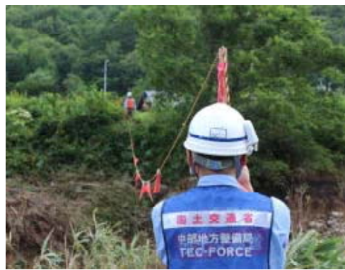
【現地調査状況】
